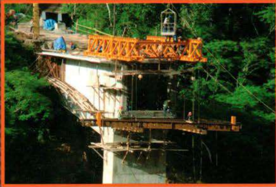
Puente Pispita - Quillabamba - Cusco
